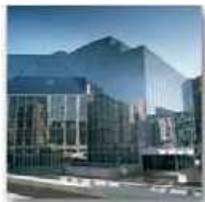
■ Gestion technique des bâtiments
